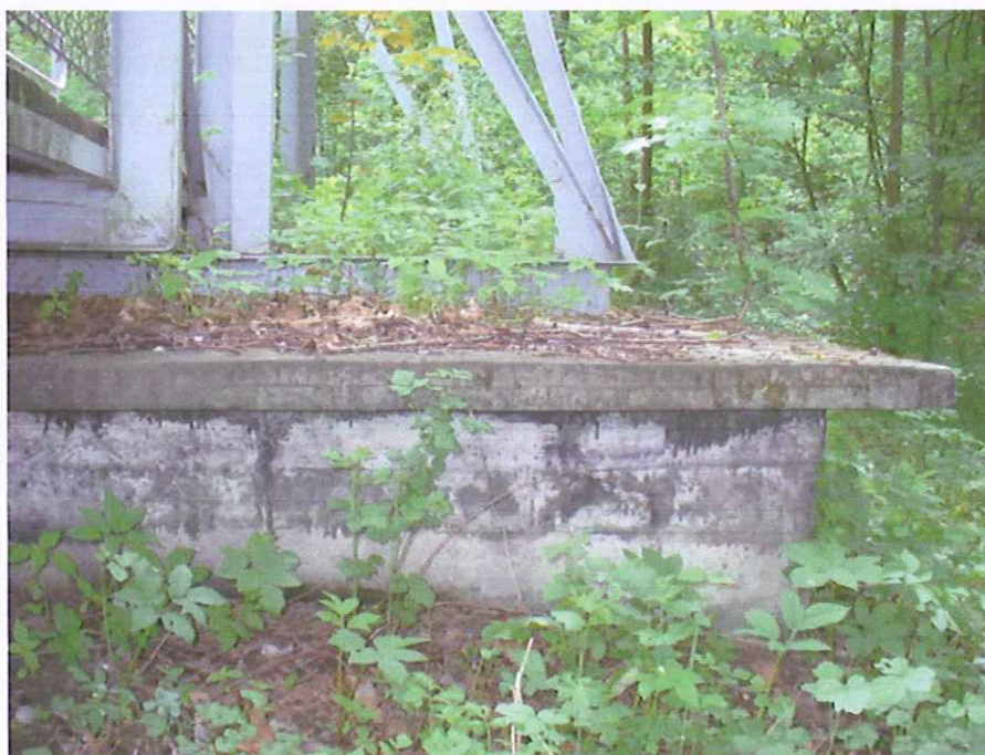
Fot. Nr 12 Widok fundamentu pylonu
