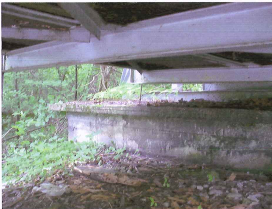
Fot. Nr 11 Widok fundamentu pylonu pod kładką
