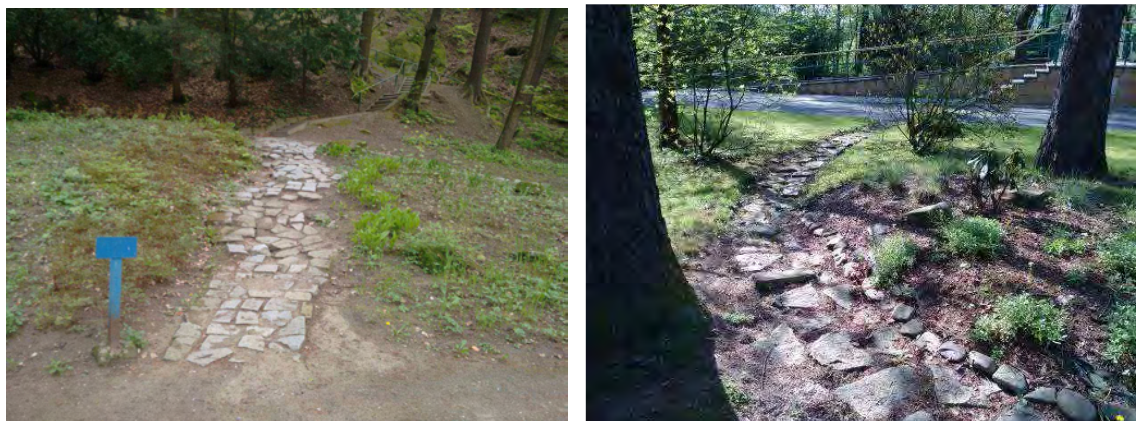
Rys. 8 Istniejące ścieżki z bloczków kamiennych
