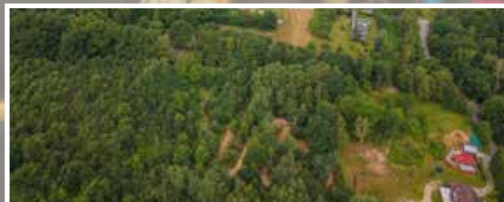
Trwają prace przy singletracku - s.7
