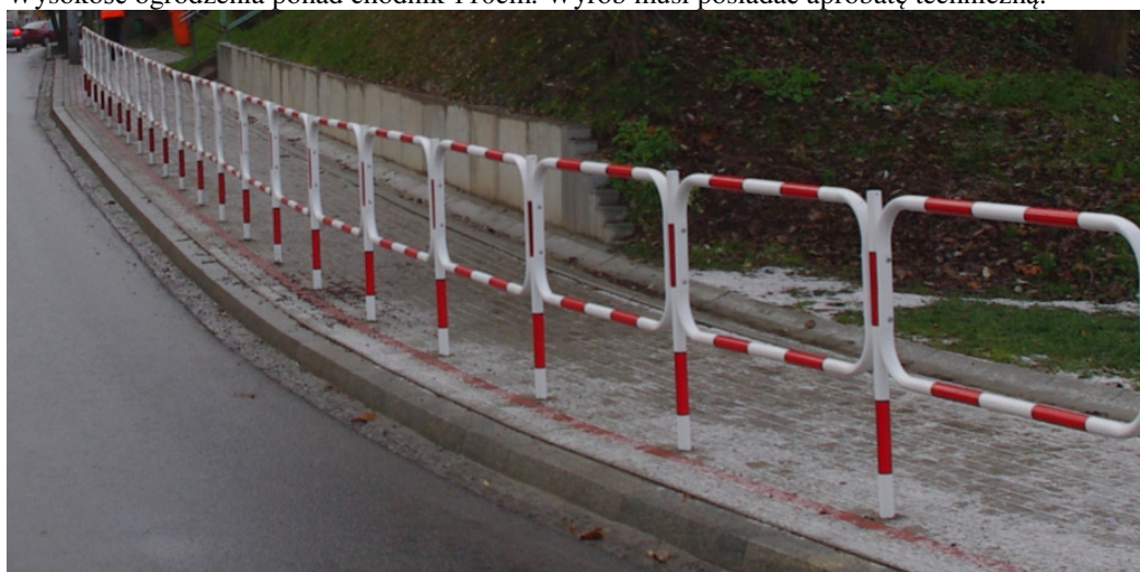
Fot.1. Ogrodzenia segmentowe oznaczone jako U-12a
