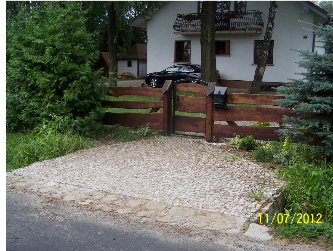
24) Działka nr 2560/14 – Wymiana słupków na wyższe, osadzenie furtki. (ZP-57)
