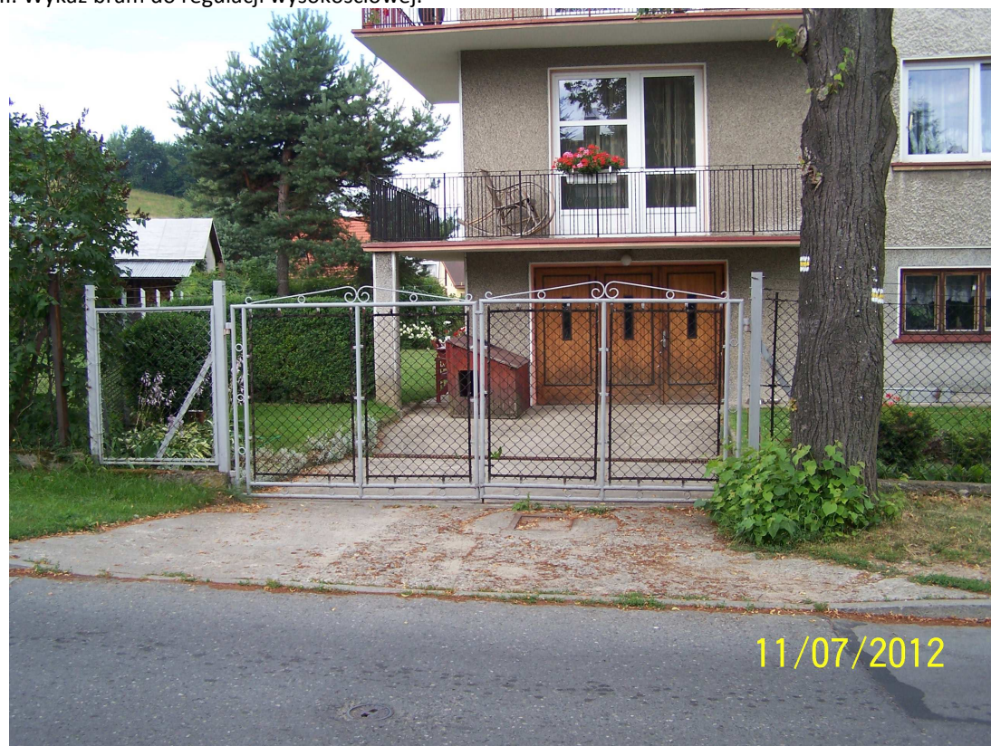
1). Działka nr 2237/14 - przespawanie zawiasów, zabezpieczenie antykorozyjne spawów (ZP-1).
