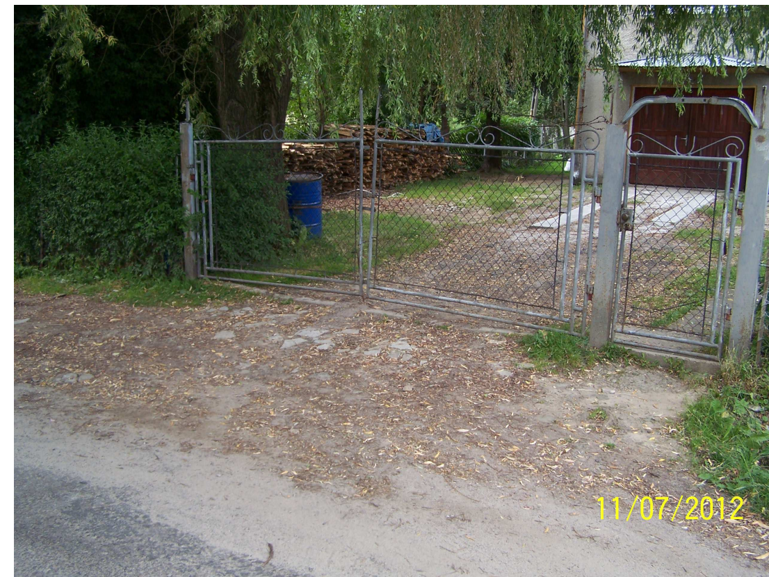
23) Działka nr 2554/1 – Rozebranie istniejącej bramy, wykonanie fundamentu, osadzenie bramy. (ZP-50)
