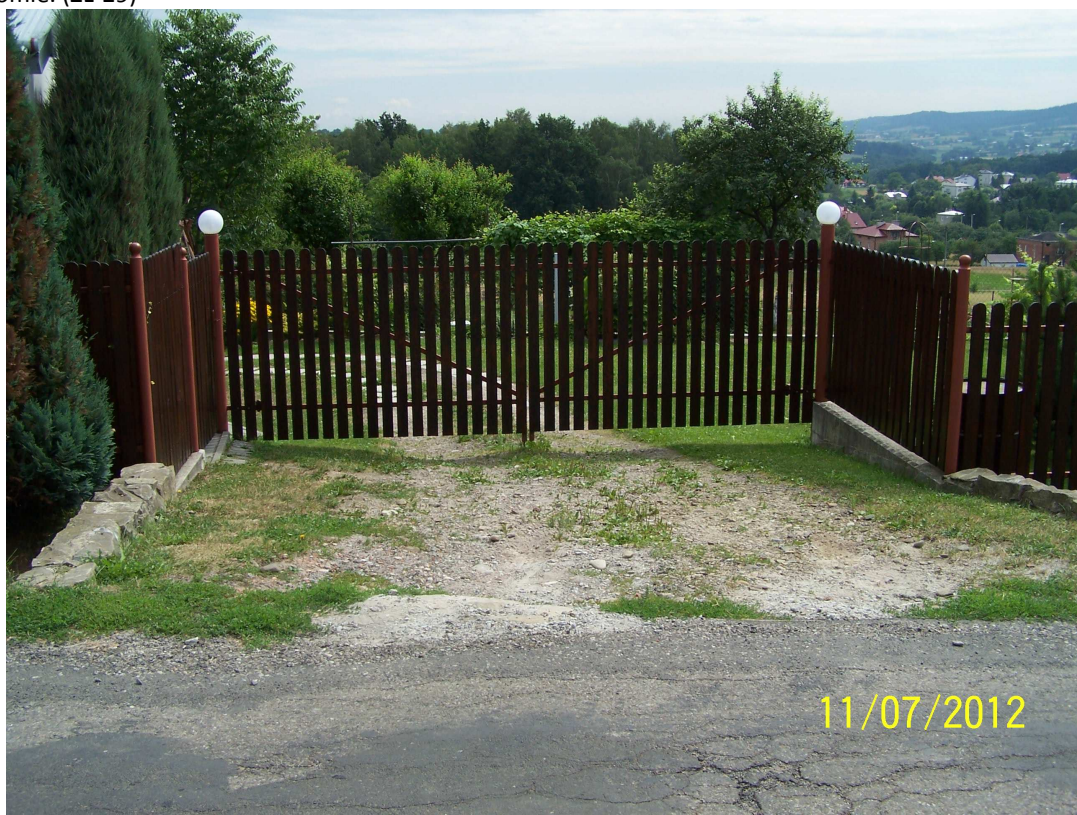
22) Działka nr 2306/7 – Rozebranie istniejącej bramy wraz z segmentami dochodzącymi do bramy, wykonanie fundamentu i słupków ogrodzeniowych w nowym poziomie, osadzenie bramy. (ZL-33)
