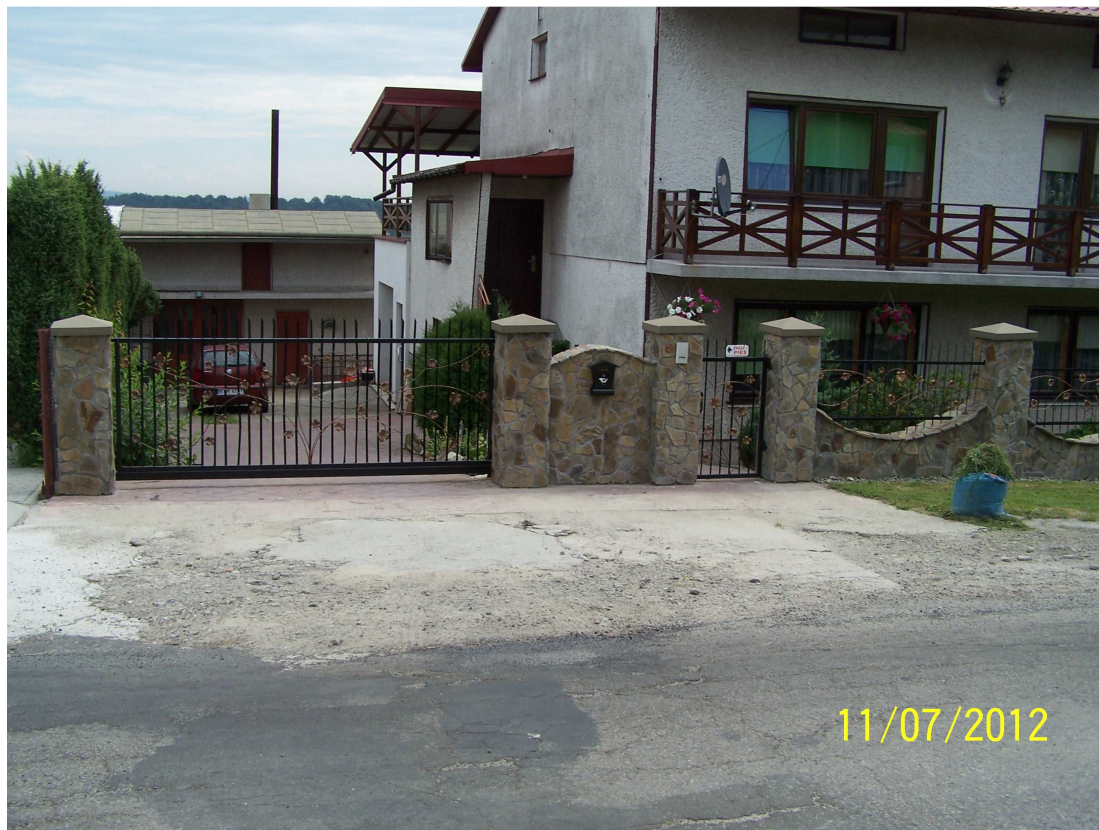
21) Działka nr 2304/4 – Demontaż istniejącej bramy i furtki, wykonanie nadbudowy istniejących słupków ogrodzeniowych. Ponowne wykonanie wykończenia z kamiennych elementów dekoracyjnych, osadzenie bramy w nowym poziomie. (ZL-29)
