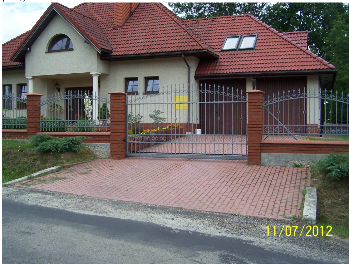
14) Działka nr 2469/10 – Regulacja wysokościowa bramy (obniżenie szyny, podmurowanie słupków klinkierem). (ZP-31)
