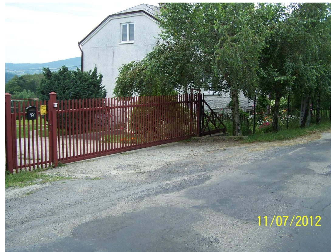
19) Działka nr 2304/10 – Rozebranie istniejącej bramy wraz z segmentami dochodzącymi do bramy, wykonanie fundamentu i słupków ogrodzeniowych w nowym poziomie, osadzenie bramy. (ZL-28)
