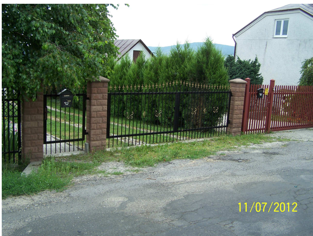
18) Działka nr 2304/9 – Rozebranie istniejącej bramy, wykonanie fundamentu i słupków ogrodzeniowych w nowym poziomie, osadzenie bramy. (ZL-27)
