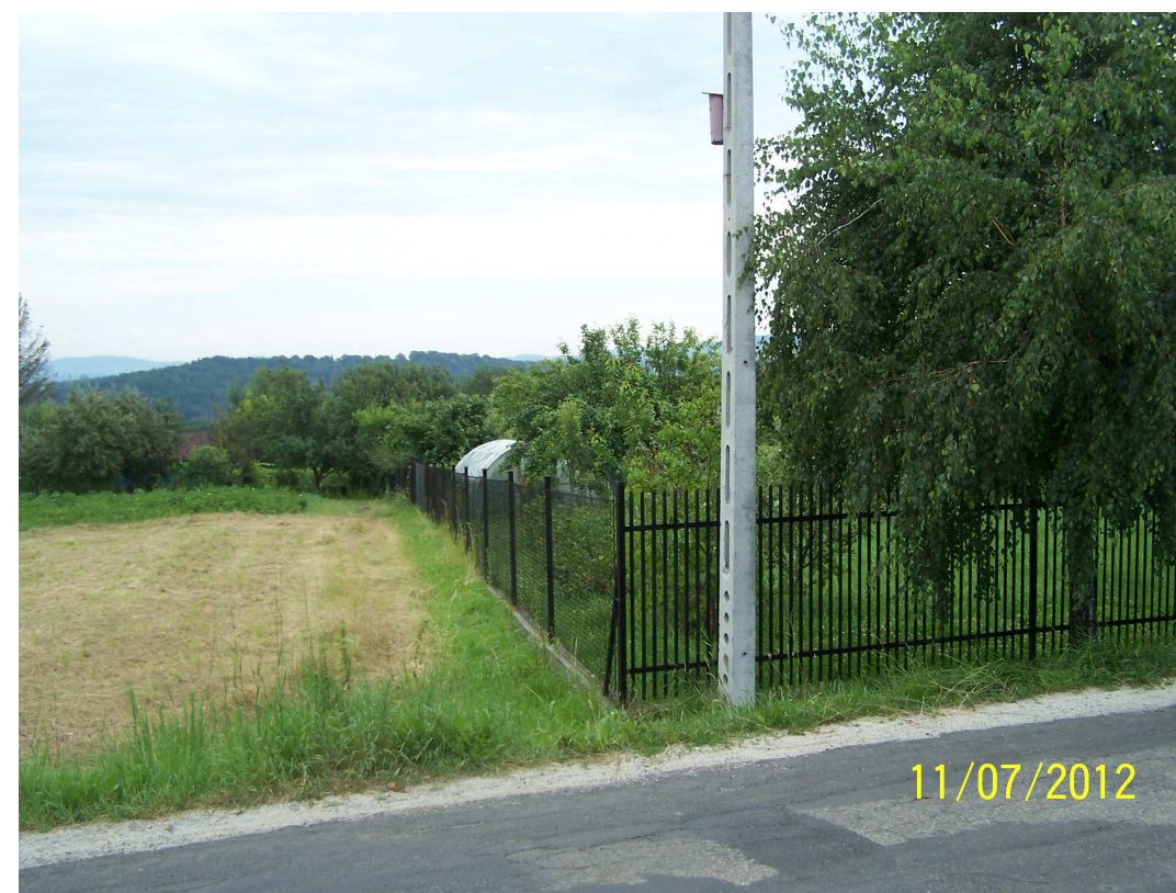
16) Działka nr 2304/8 – Rozebranie istniejącego ogrodzenia na dł. 3 segmentów. Wykonanie nowych murków ogrodzeniowych, wraz z osadzeniem słupków ogrodzeniowych. Wymagana przeróbka 2 segmentów „po skosie”. Jeden z segmentów rozciąć w połowie i przyspawać na zawiasach do słupków ogrodzeniowych (w miejscu projektowanego zjazdu) (ZL-26)
