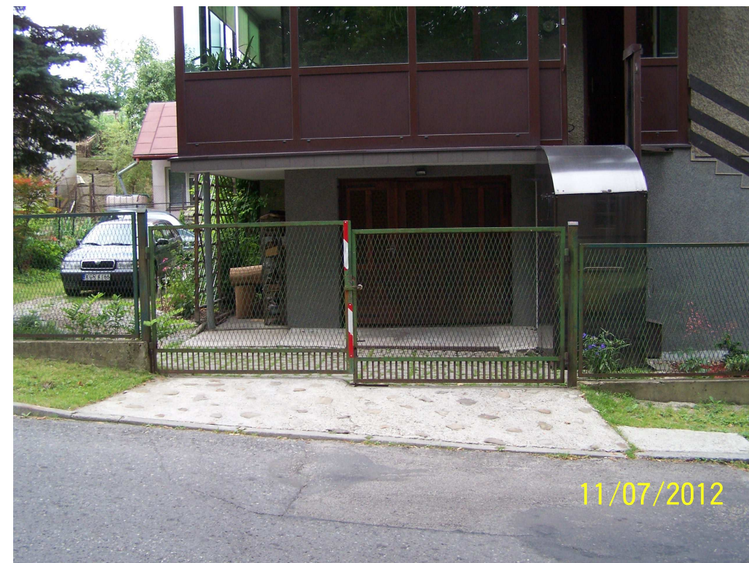
3) Działka nr 2248/2 - przespawanie zawiasów, zabezpieczenie antykorozyjne spawów (ZP-11).
