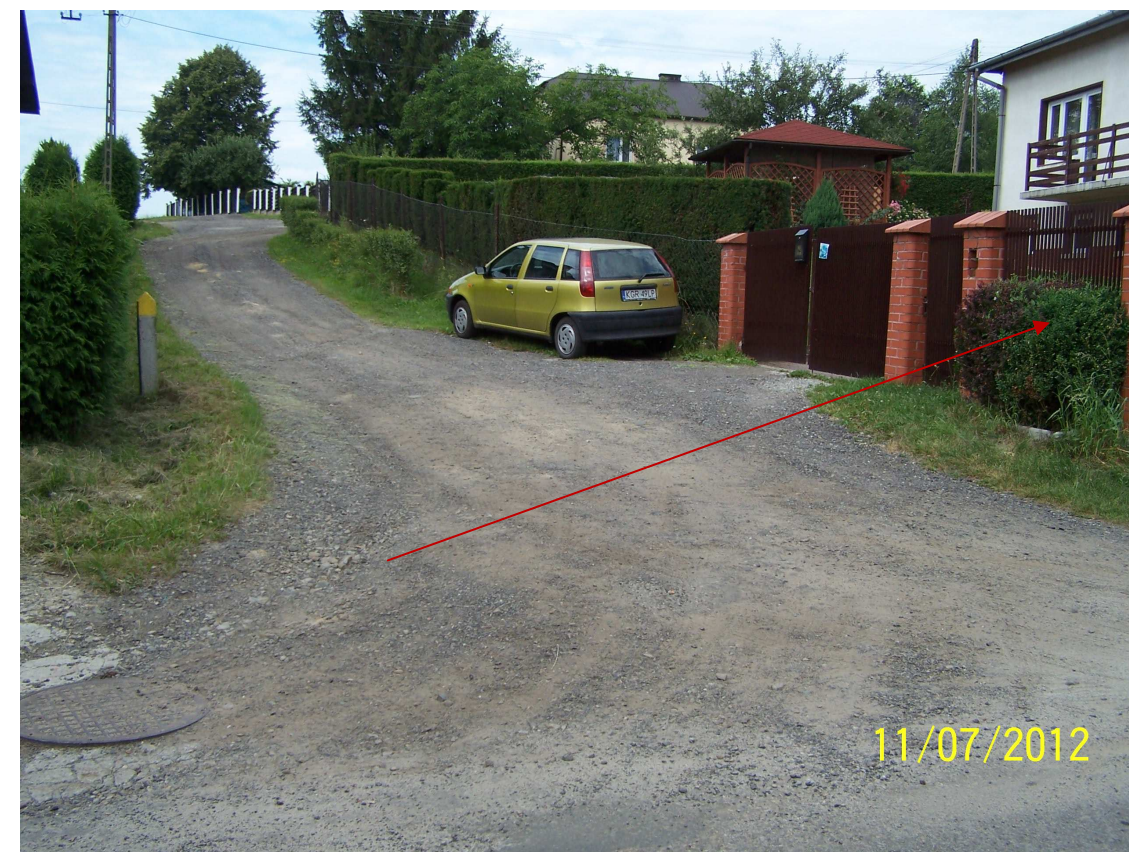
6). Działka nr 2554/6. Ogrodnie ze metalowych segmentów. Słupki wykonane z cegły klinkierowej. Odbudować słupek w nowej lokalizacji, połączyć z siatką metalową.
