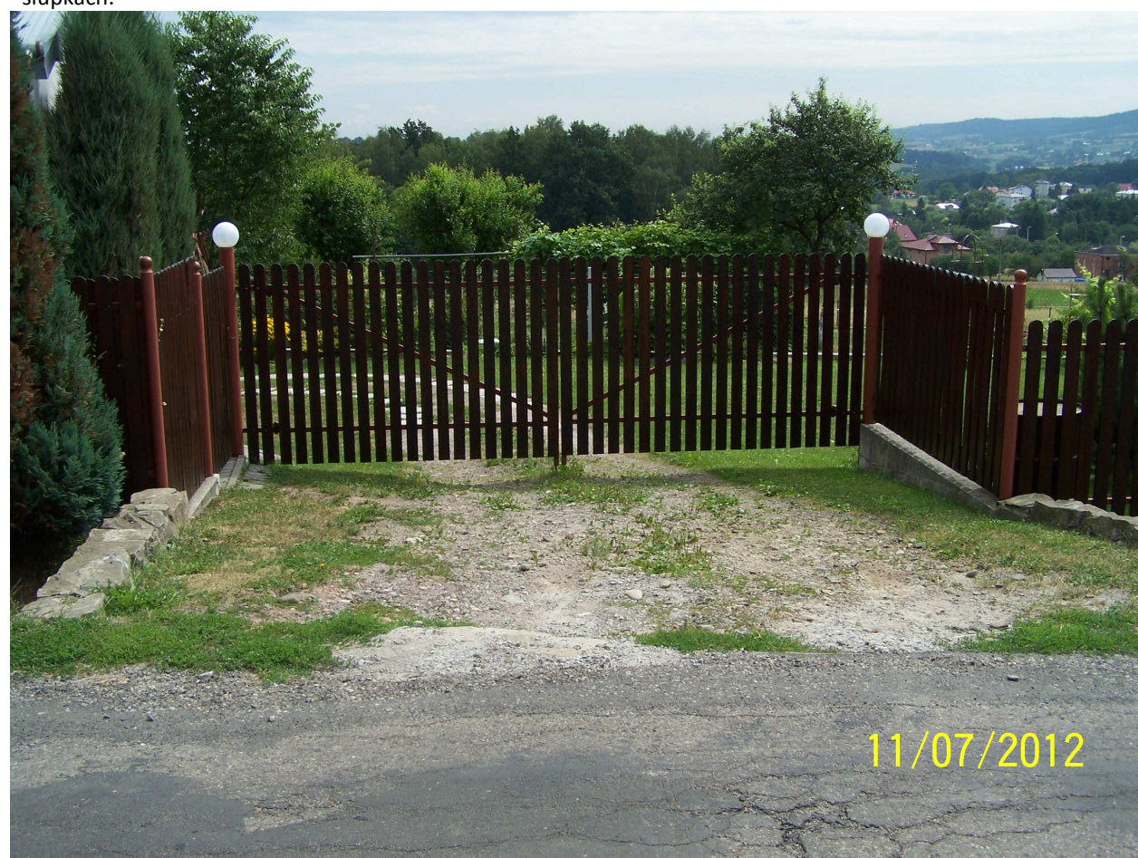
4). Działka nr 2306/8 - przełożenie ogrodzenia na dł. 28m. Ogrodnie ze drewnianymi sztachetami na konstrukcji stalowej. Wykonać nowe murki z wyprowadzeniem pod słupki. Istniejące segmenty przyspawać do nowej lokalizacji. Zabezpieczyć antykorozyjnie. Pomalować metalowe elementy.
