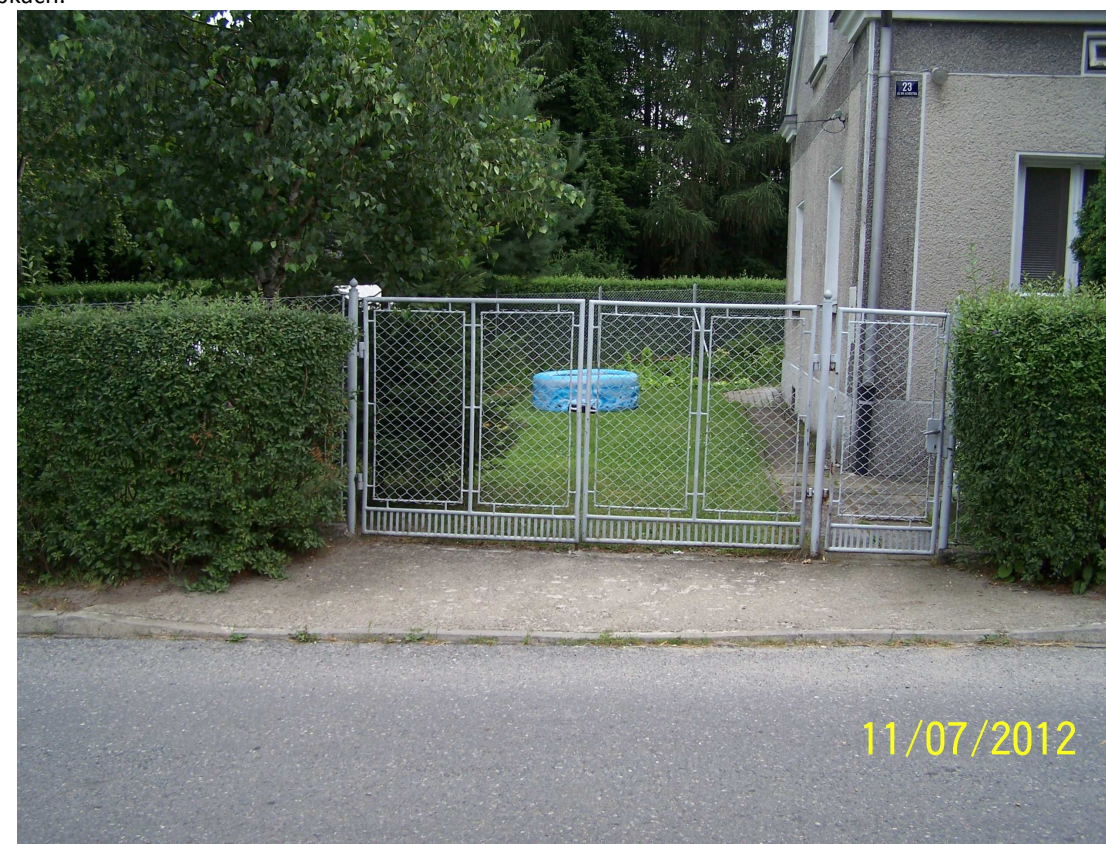
2). Działka nr 2273/2 - przełożenie ogrodzenia na dł. 15m. Ogrodnie z plecionej siatki stalowej na metalowych słupkach, obsadzonej żywopłotem.
