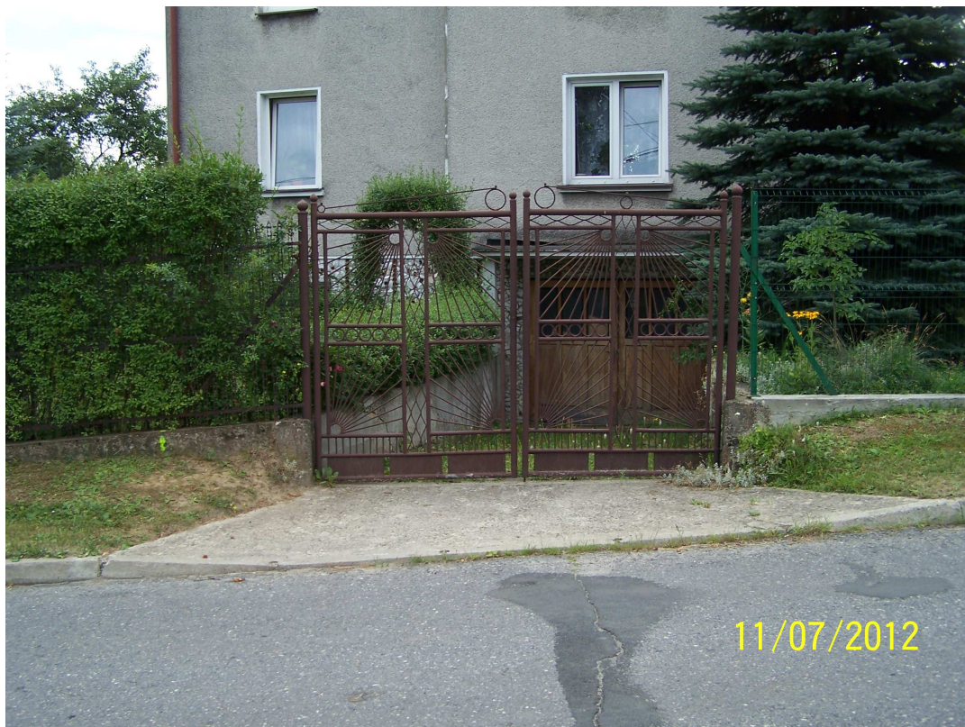
9) Działka nr 2275/1 - przepawanie zawiasów, zabezpieczenie antykorozyjne spawów. (ZL-14)
