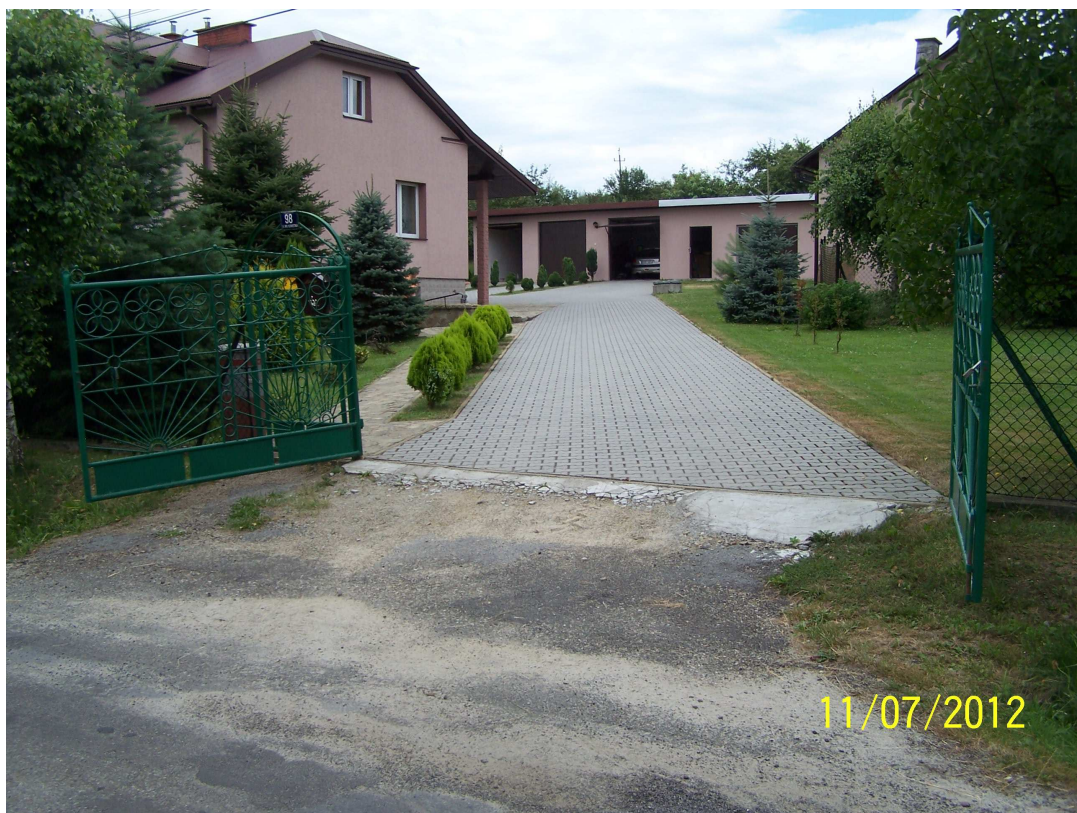
17) Działka nr 2514/1 – przepawanie zawiasów, zabezpieczenie antykorozyjne spawów (ZP-42)
