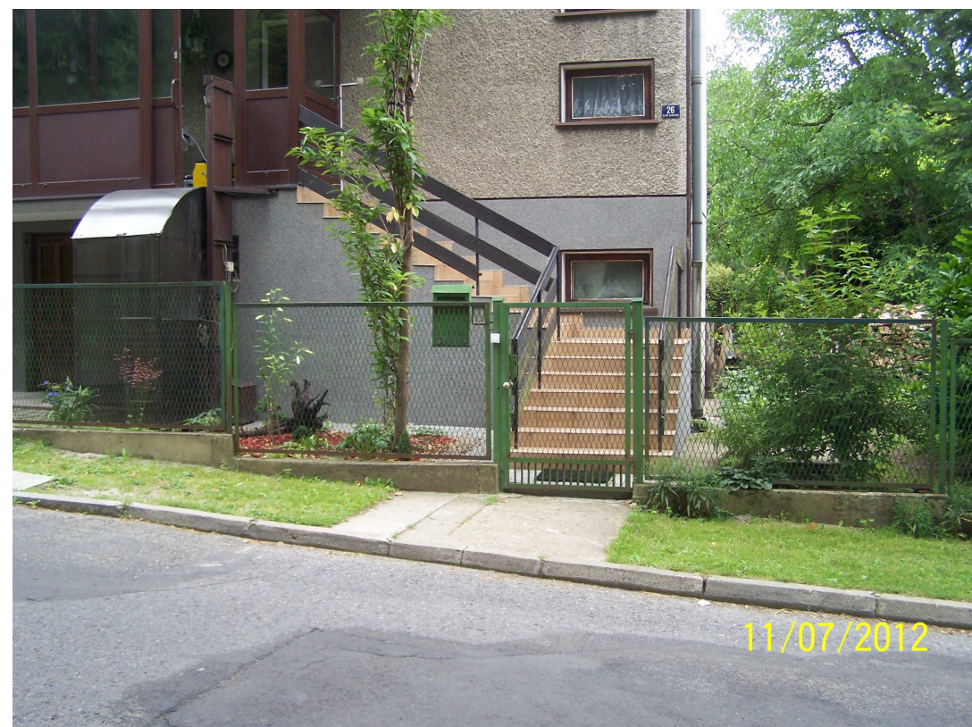
2). Działka nr 2248/2 - przespawanie zawiasów, zabezpieczenie antykorozyjne spawów (ZP-10).
