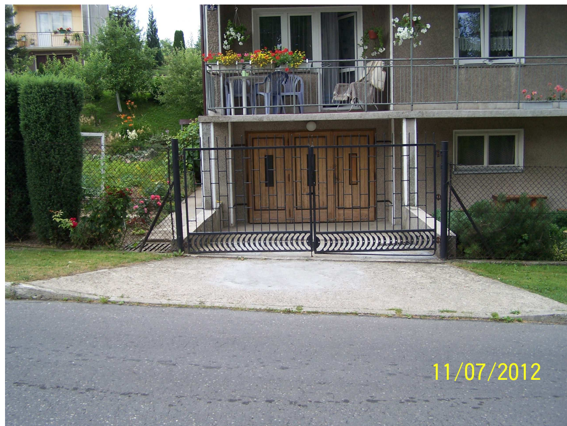
5) Działka nr 2248/2 - przespawanie zawiasów, zabezpieczenie antykorozyjne spawów (ZP-12).
