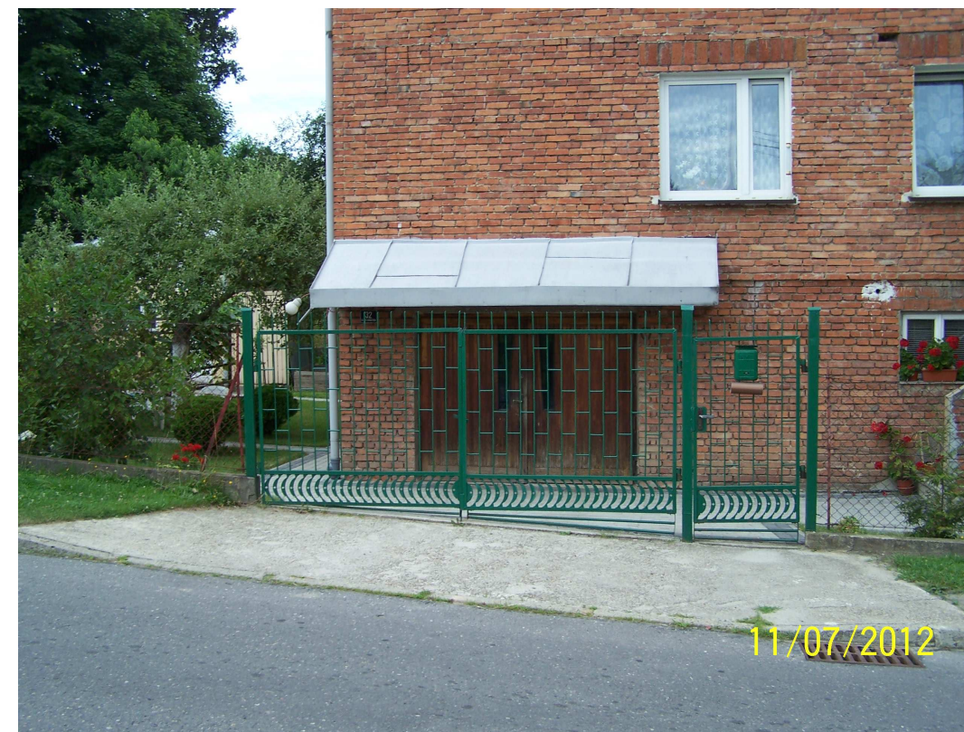
7) Działka nr 2248/4 - przespawanie zawiasów, zabezpieczenie antykorozyjne spawów. (ZP-15)
