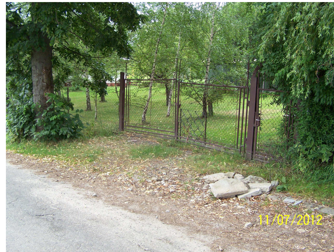
5). Działka nr 2554/6 - przełożenie ogrodzenia na dł. 51m. Ogrodnie z plecionej siatki stalowej na metalowych.
