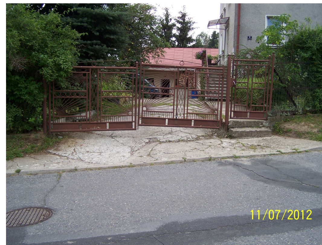
8) Działka nr 2275/1 - przespawanie zawiasów, zabezpieczenie antykorozyjne spawów. (ZL-13)
