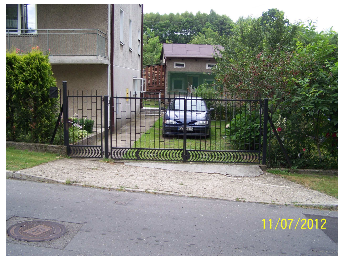
4) Działka nr 2248/2 - przespawanie zawiasów, zabezpieczenie antykorozyjne spawów. (ZP-13)
