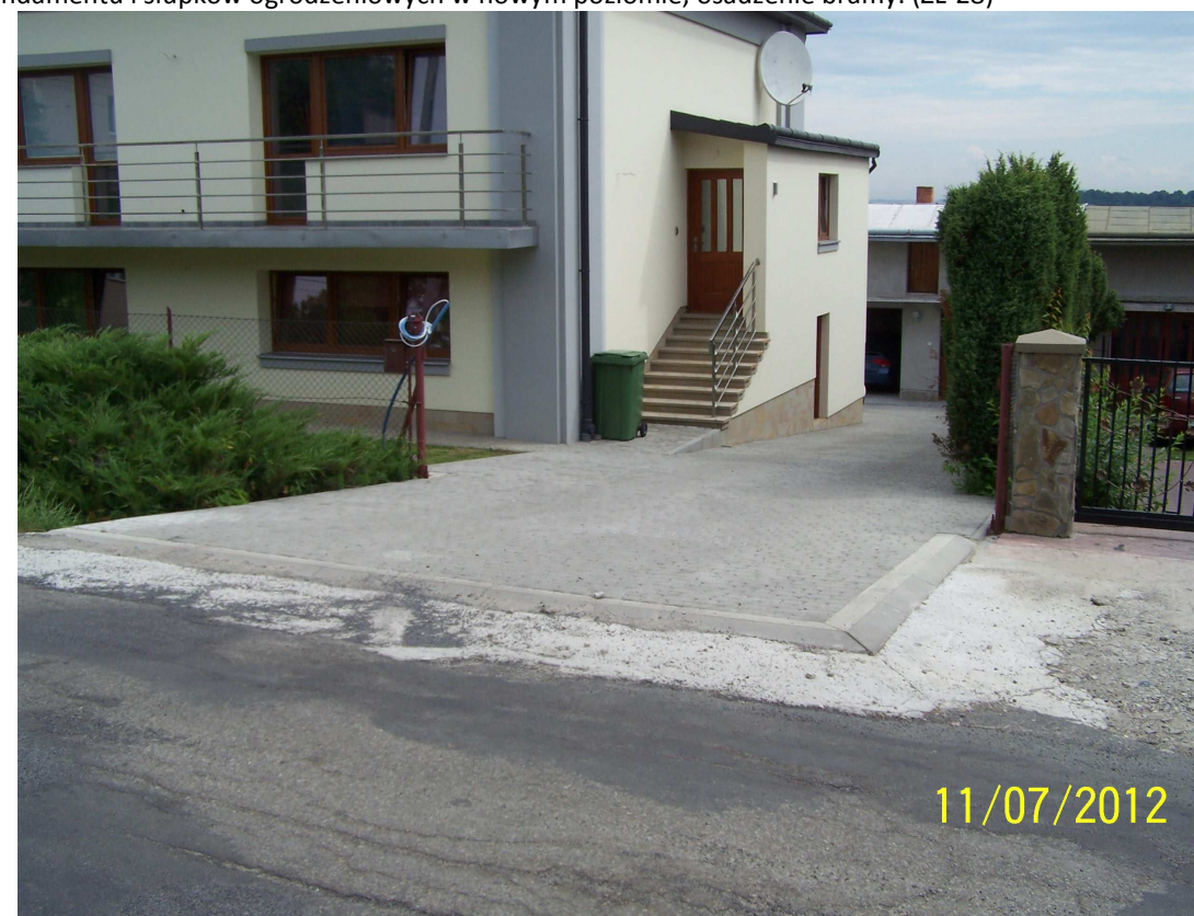
20) Działka nr 2304/4 – Rozebranie istniejącej bramy wraz z segmentami dochodzącymi do bramy, wykonanie fundamentu i słupków ogrodzeniowych w nowym poziomie, osadzenie bramy. (ZL-29)
