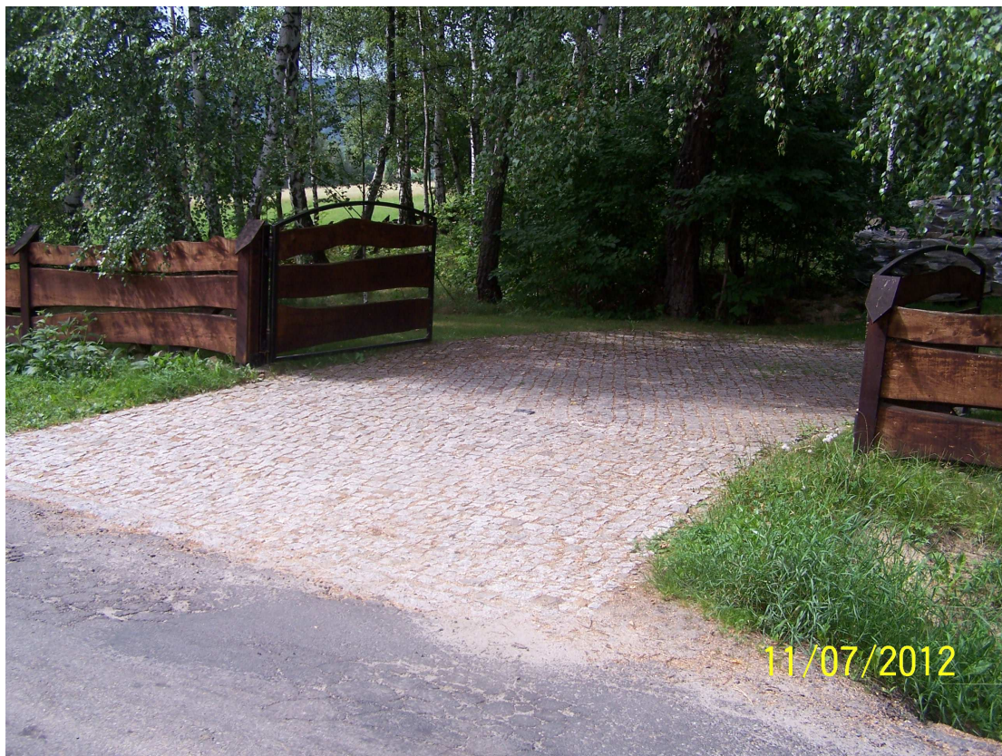
25) Działka nr 2560/14 – Wymiana słupków na wyższe, osadzenie furtki. (ZP-58)
