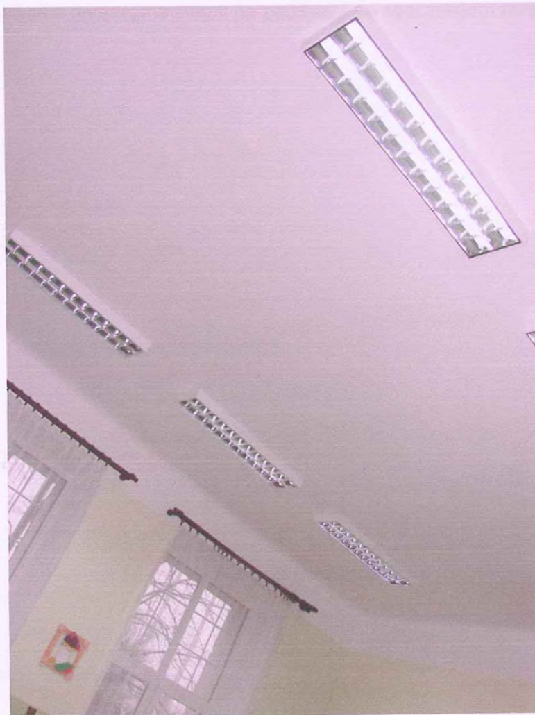
widok na strop nad parterem (pod adaptowanymi pomieszczeniami)
