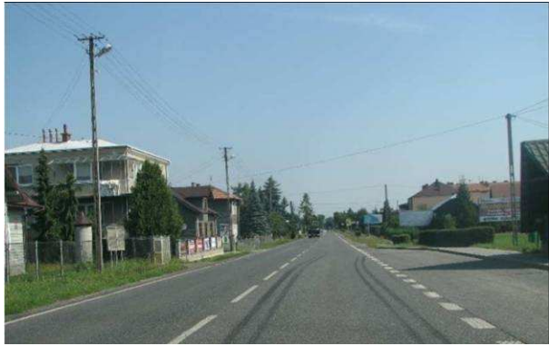
Fot. 3.2. Skrzyżowanie obwodnicy Gorlic z DK nr 28 w m. Ropica Polska (szkoła)
