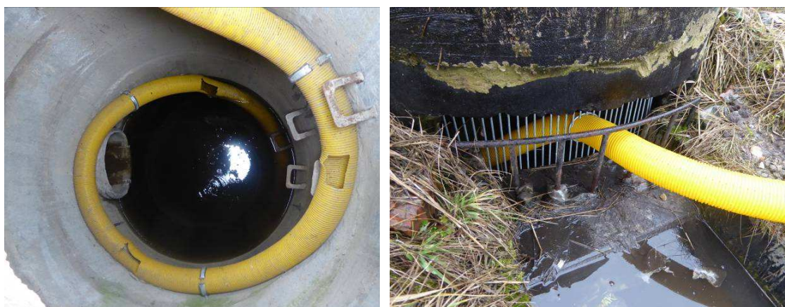
Rys. 6.3. Przykładowe rozwiązanie zastosowania rury ucieczkowej
